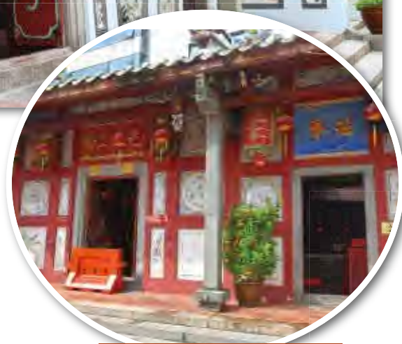
柔佛古庙庙门的墙壁在 1996 年重建修复时漆上红色。
